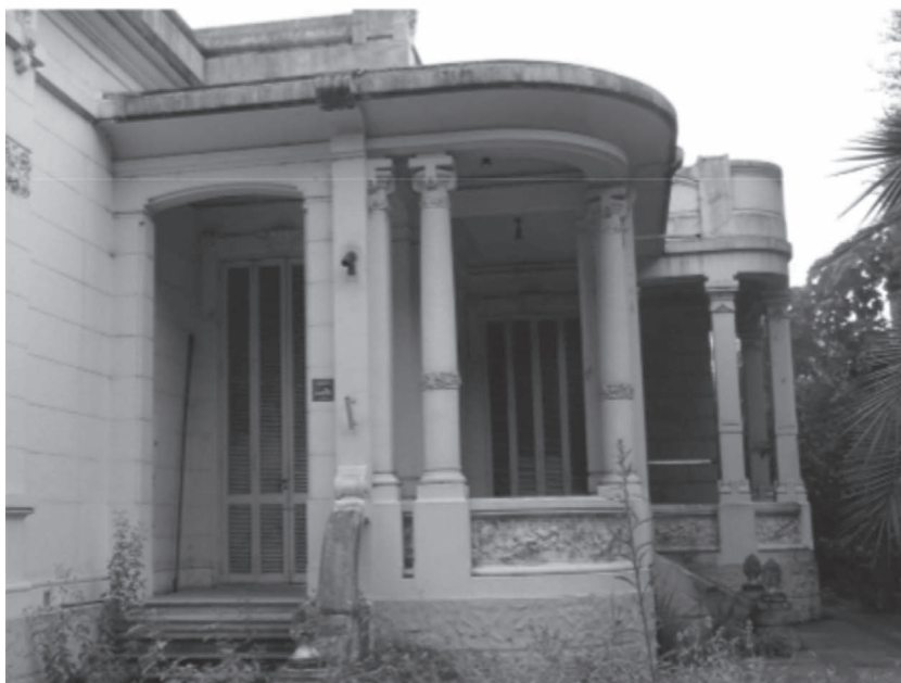
Estado de la casa en el año 2017.
