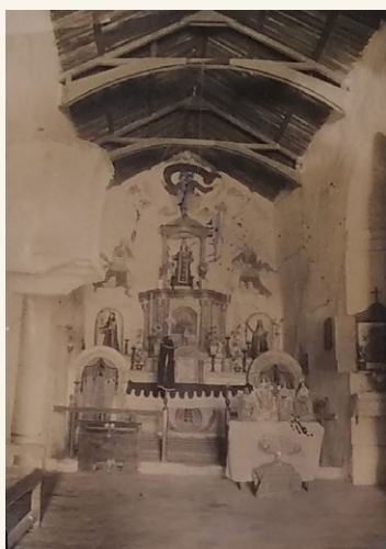
La Rinconada, interior de la iglesia.
